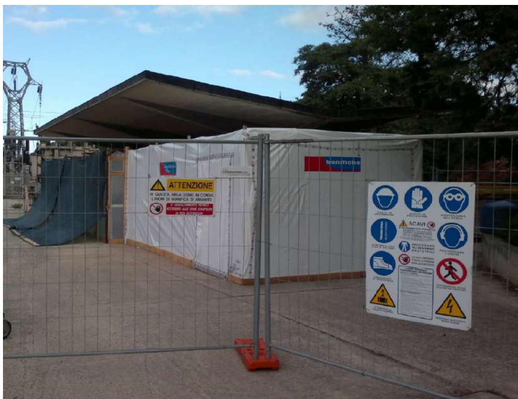
Figura 3: Esempio di area confinata cantiere rimozione amianto
